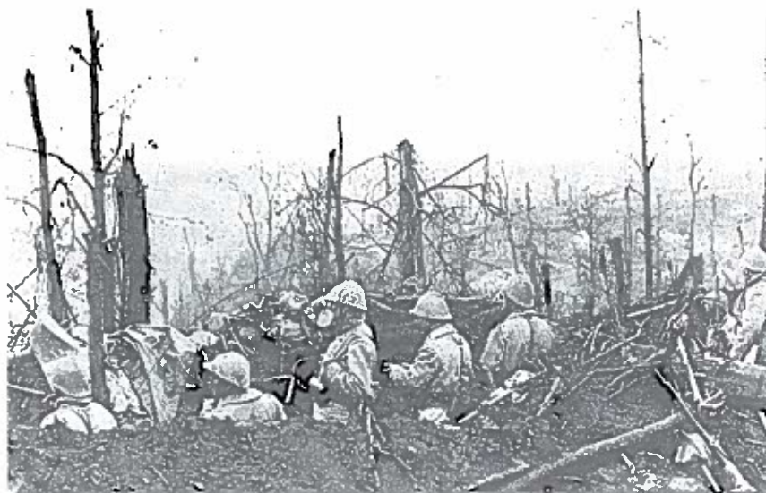
Une tranchée en 1917
